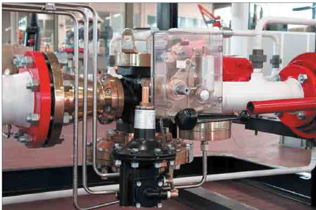
Блок редуцирования с регулятором в исполнении CB-SRS. Поток газа справа налево.
