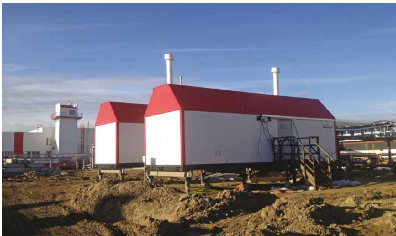
ПНР Комплекса водоочистного ВОДОПАД-100 с ПВ-60 на Пяяхинском ГКМ
