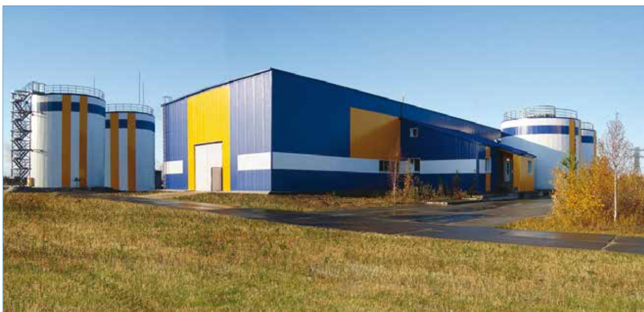
Станция «Водопад-8000», г. Тарко-Сале
