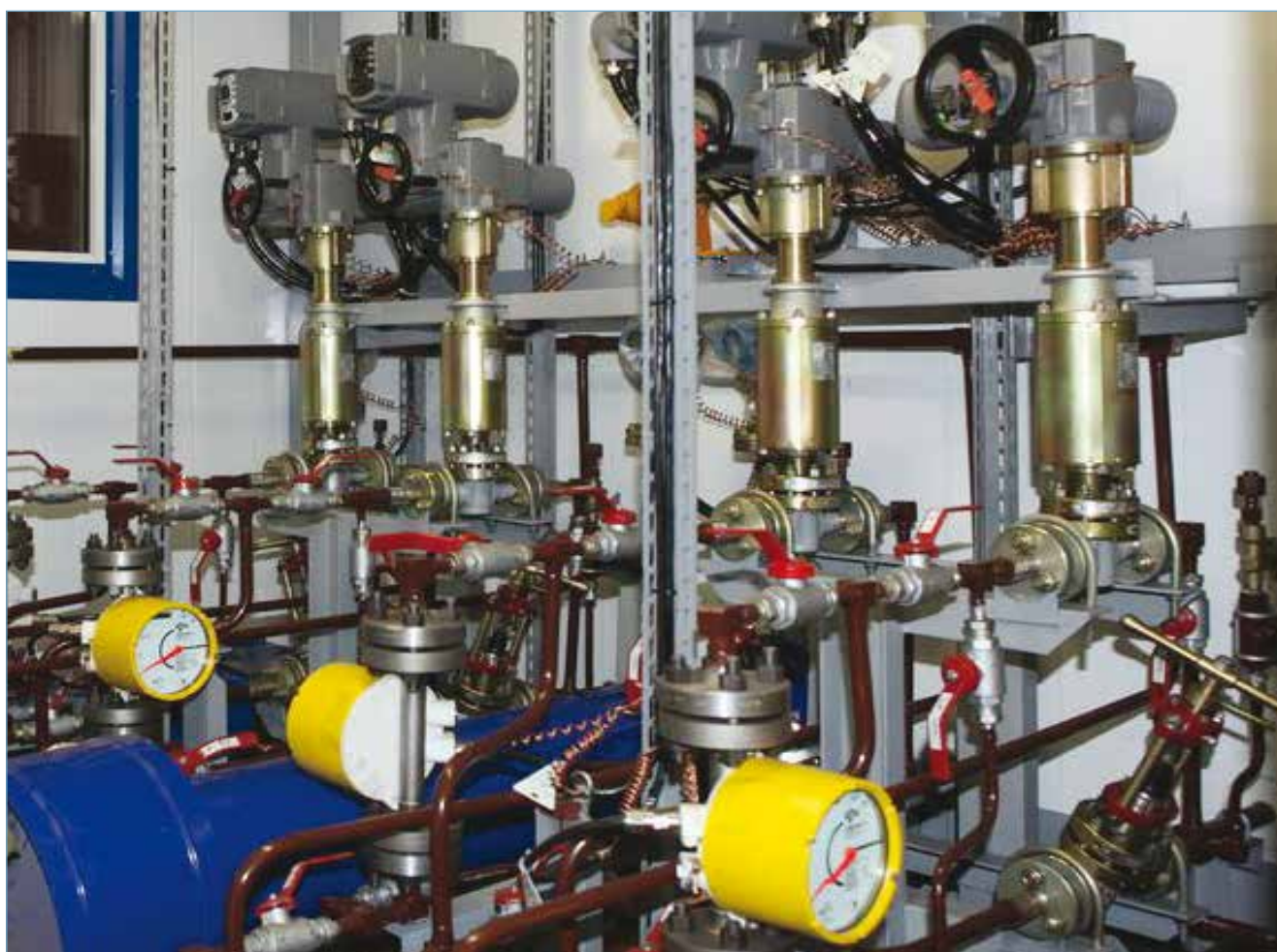
Блок распределения метанола 1-T38
