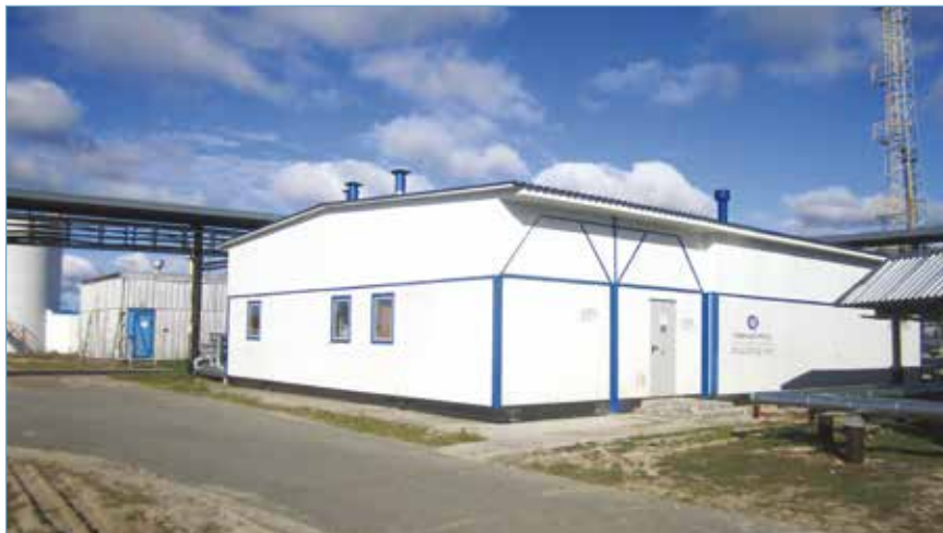
Водоочистной комплекс «Водопад-500» в блочно-модульном исполнении на объекте ООО «Газпром трансгаз Сургут»
