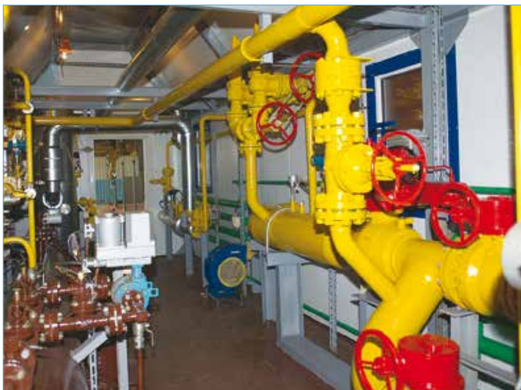
Установка выхода газа
